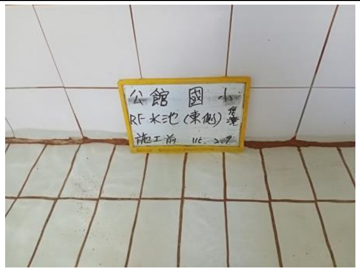
頂樓水塔-1 施工前
