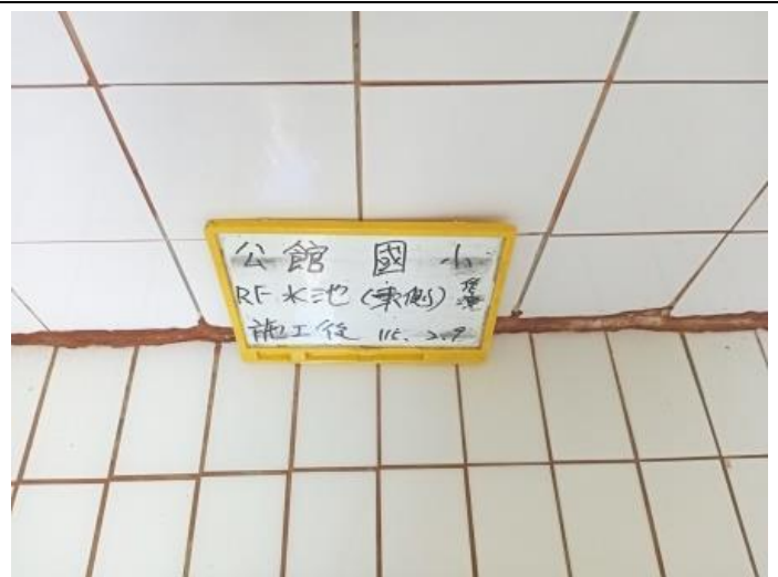
頂樓水塔-1 施工後
