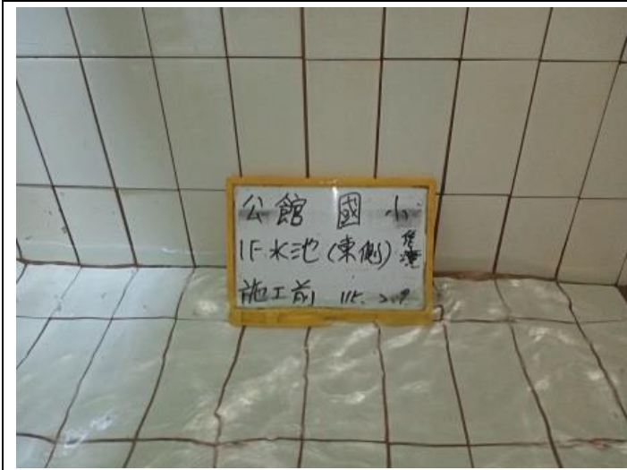
1F 蓄水池-1 施工前
