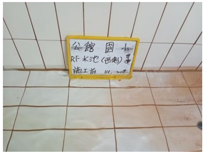
頂樓水塔-2 施工前
