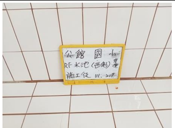
頂樓水塔-2 施工後
