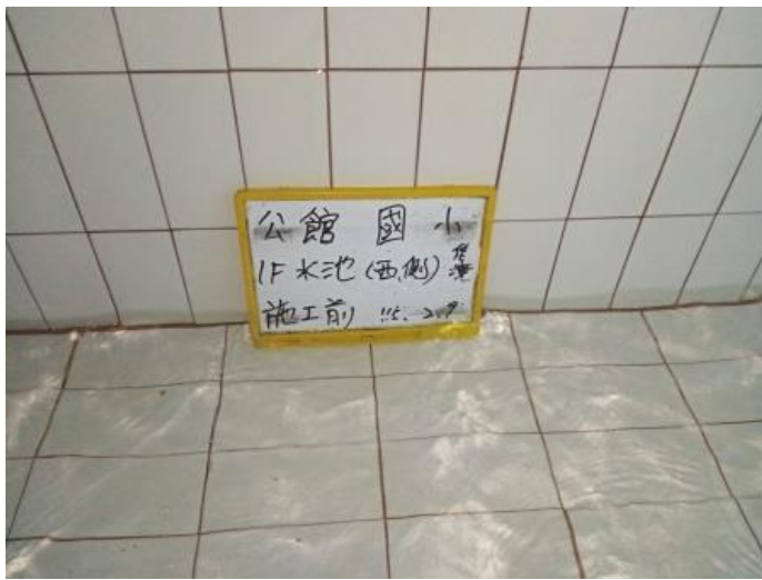
1F 蓄水池-2 施工前
