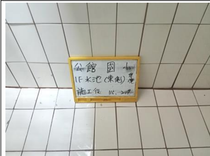
1F 蓄水池-1 施工後
