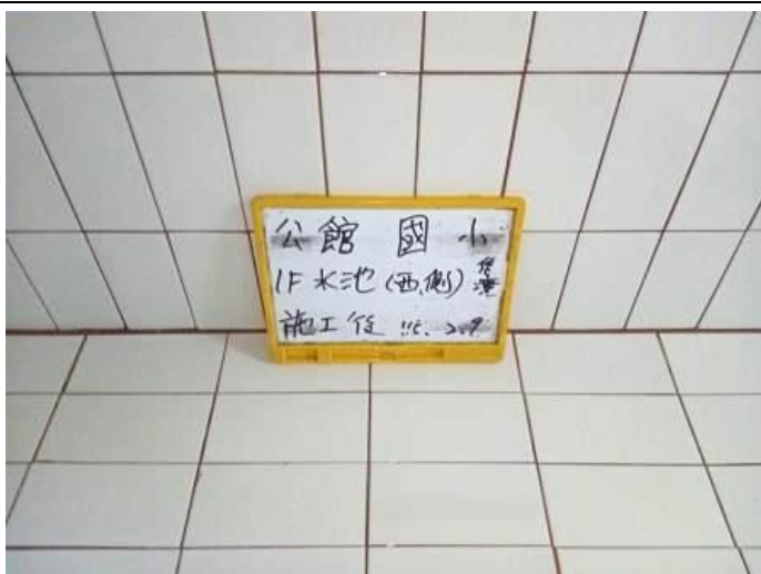
1F 蓄水池-2 施工後
