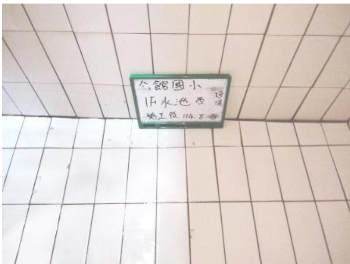
1F 蓄水池-2 施工後
