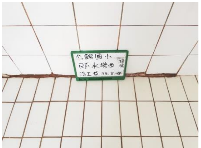
頂樓水塔-2 施工後
