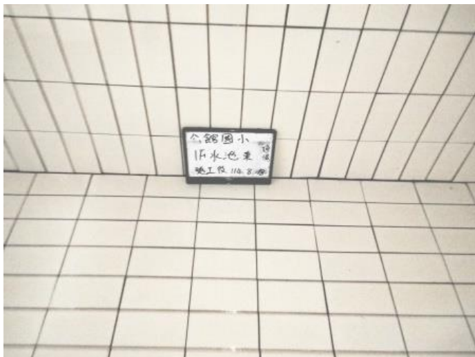
1F 蓄水池-1 施工後
