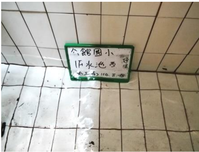
1F 蓄水池-2 施工前
