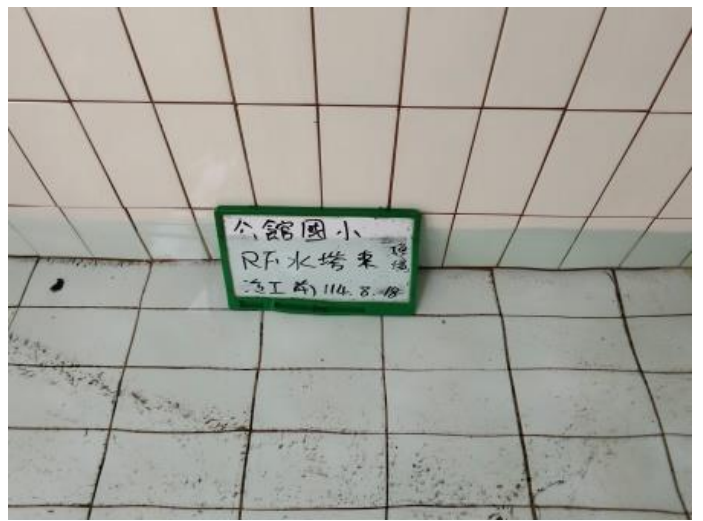
頂樓水塔-1 施工前
