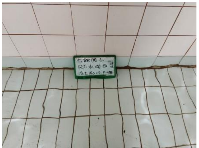
頂樓水塔-2 施工前
