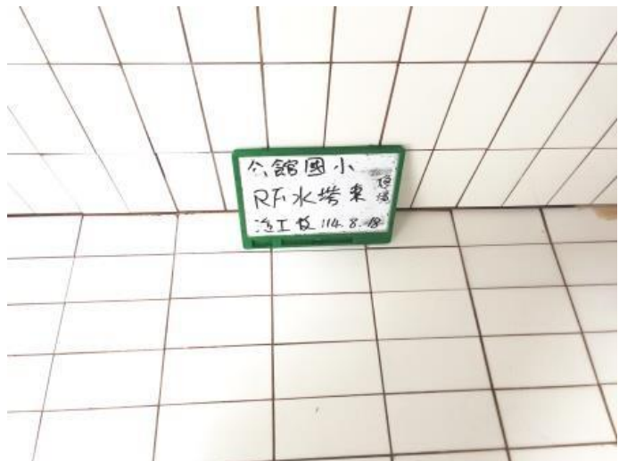
頂樓水塔-1 施工後
