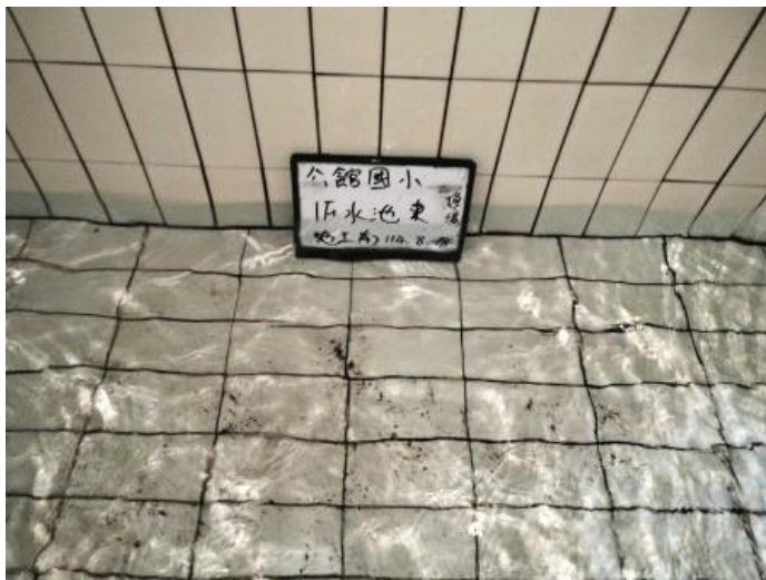
1F 蓄水池-1 施工前
