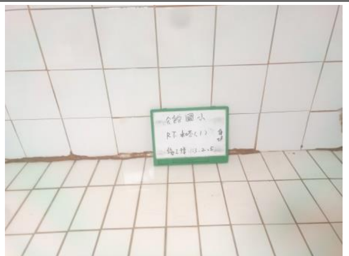
頂樓水塔-1 施工後
