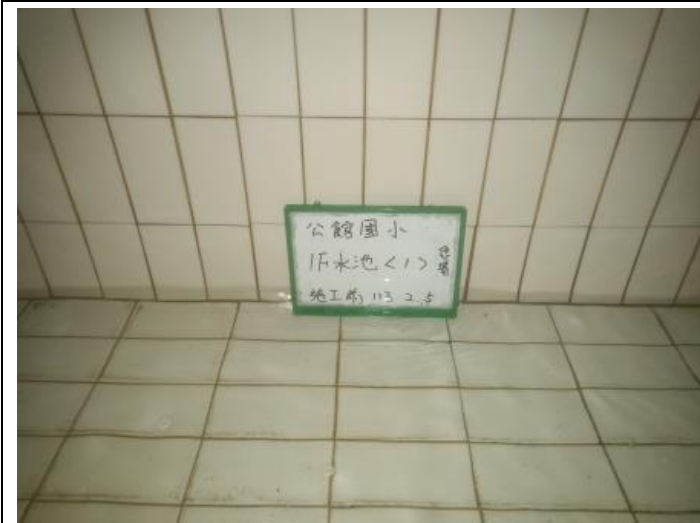
1F 蓄水池-1 施工前
