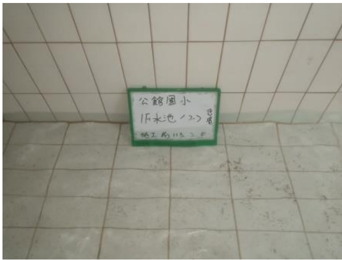
1F 蓄水池-2 施工前
