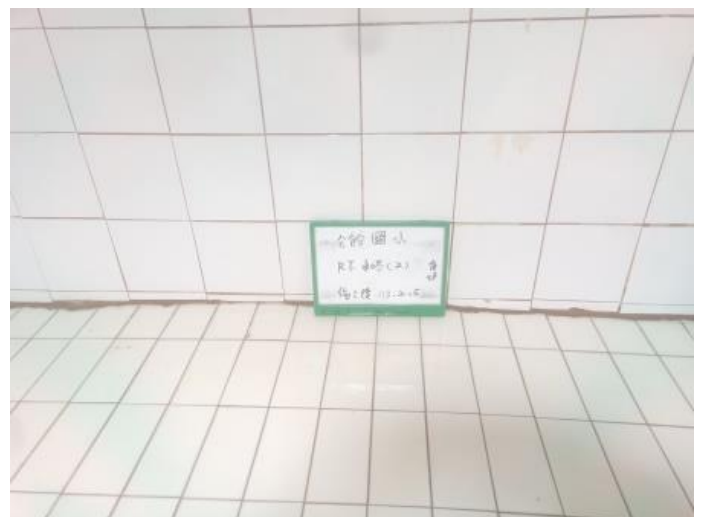
頂樓水塔-2 施工後
