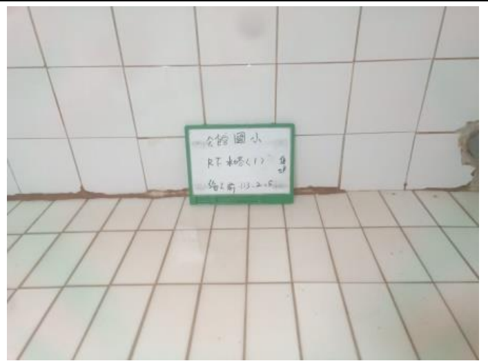
頂樓水塔-1 施工前
