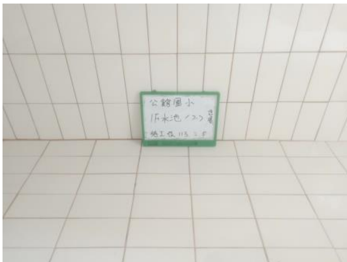
1F 蓄水池-2 施工後
