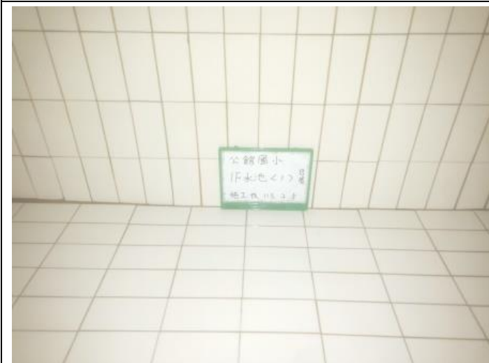
1F 蓄水池-1 施工後
