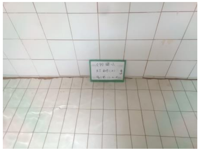
頂樓水塔-2 施工前
